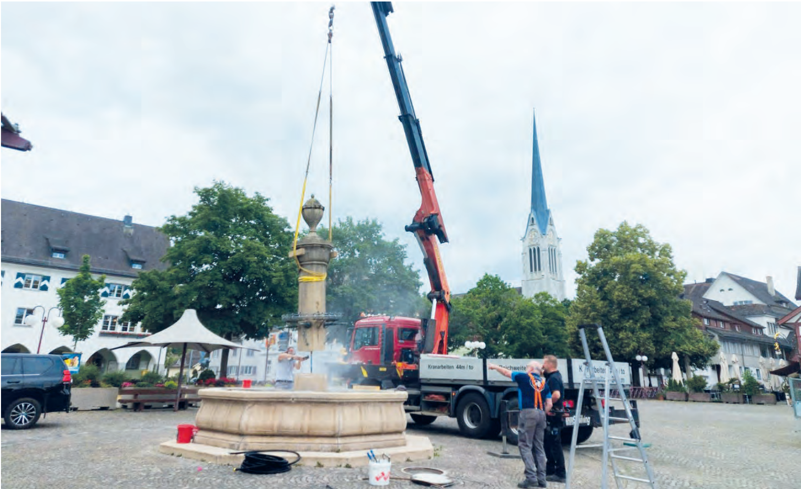
Vergangenen Dienstagvormittag wurde der Marktplatzbrunnen zwecks erster Reparaturarbeiten auseinandergenommen. Bild: pd
