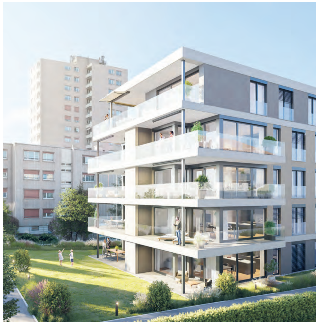
Das Mehrfamilienhaus an der Poststrasse wird ca. Anfang 2024 bezugsbereit sein.
