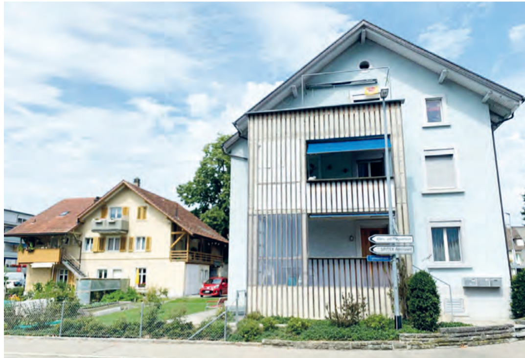
Wo heute diese beiden Gebäude stehen, sollen bis Ende 2023 rund 30 Alterswohnungen realisiert werden. Bild: pd
