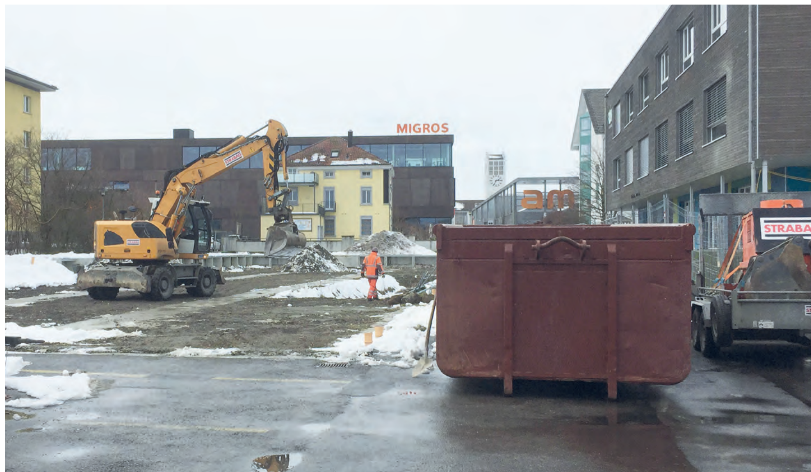
Seit Montag wird beim Radolfzellerpark geschaufelt und gewerkt. Der Park, der im Sommer fertig werden soll, wird künftig die Kirchstrasse und die Bahnhofstrasse miteinander verbinden und als grünes Stadtzentrum auch zum Treffpunkt, Aufenthaltsort und zur Begegnungszone.
