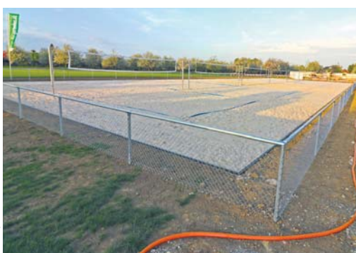
Fertig erstellt: die sechs neuen Beachfelder im Tellenfeld.
