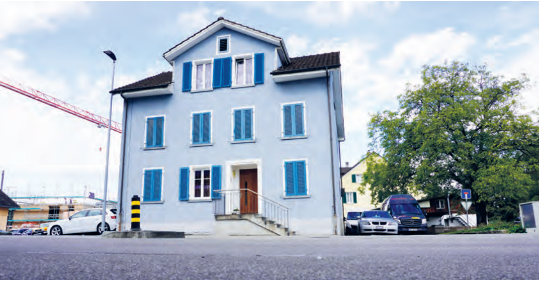
Alle drei Wohnungen an der Unteren Bahnhofstrasse 3 sind aktuell vermietet.
