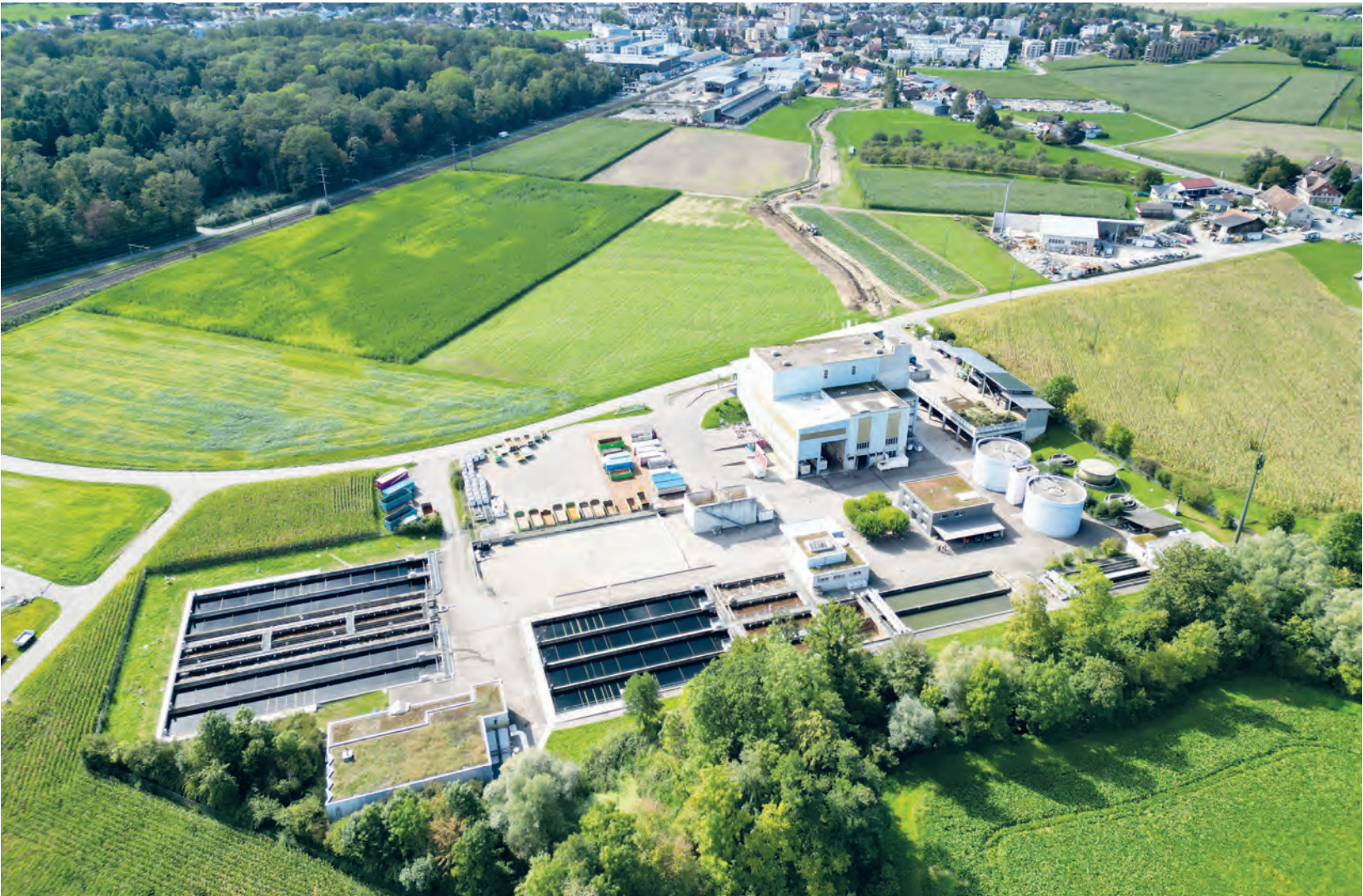
Die Abwasserreinigungsanlage Moos aus der Vogelperspektive: Hier fliesst das Abwasser von Amriswil und umliegenden Gemeinden zusammen.
