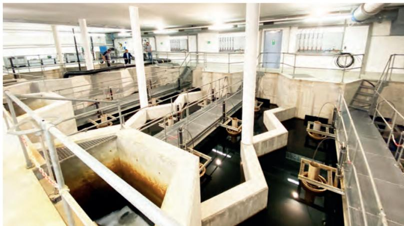
Derzeit wird in einem von insgesamt vier Filterbecken mit Aktivkohle gearbeitet. In einem guten Jahr sollen alle vier umgerüstet sein.
