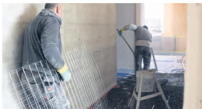
**Im Neubau entsteht gerade der Betonboden, der nach dem Aushärten versiegelt wird.**
