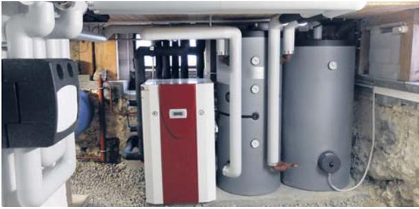
Wärmepumpen wandeln die Umweltwärme tieferer Temperatur in Heizwärme höherer Temperatur um. Das Bild zeigt eine Wärmepumpe, die Erdwärme mithilfe einer Erdsonde nutzt.
